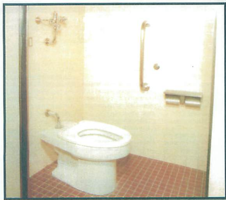
トイレブースもスケールアップしています。
